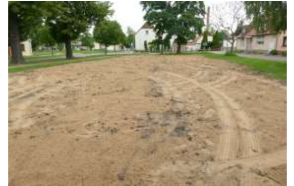
22.07.2021 – Sand aufbringen + einfräsen
